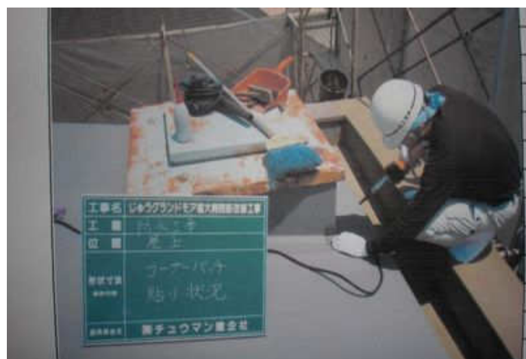
塩ビシート露出機械固定工法
