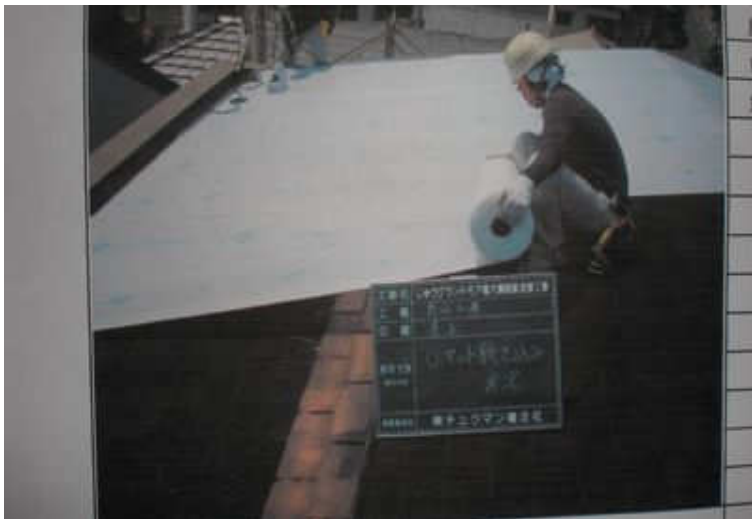
塩ビシート露出機械固定工法
