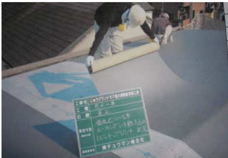
塩ビシート露出機械固定工法
