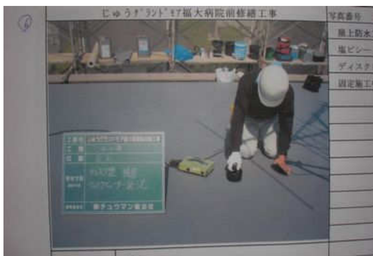
塩ビシート露出機械固定工法
