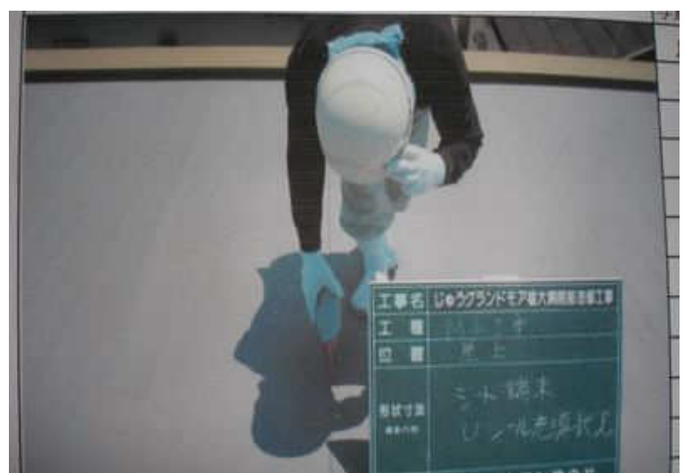
塩ビシート露出機械固定工法
