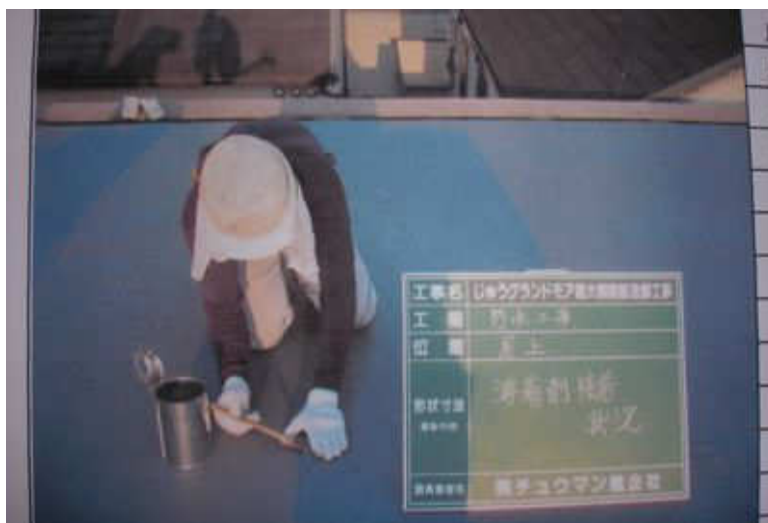
塩ビシート露出機械固定工法
